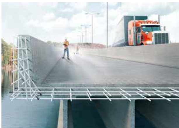
Zbrojenie z włókna szklanego Schöck Combar® jest zamawiane i montowane podobnie jak zwykła stal zbrojeniowa
